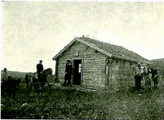
På veibefaring i Finnmark (Lakselv—Alta) Krag stående ved døren. Overingeniør Saxegaard tilhøst.
